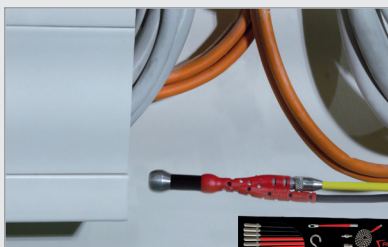
Šachty a podlahové kanály
