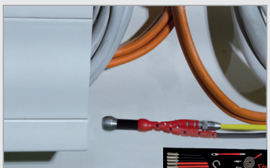
Schächte und Unterflurkanäle
