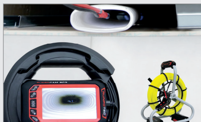
Lüftungs- und Wartungsinspektion
